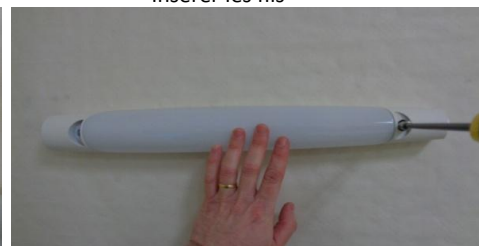
Fixer à travers l'applicque et tester l'allumage.
