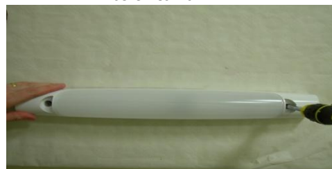
Fixer à travers l'applique et tester l'allumage.
