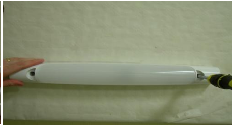
Fixer à travers l'applique et tester l'allumage.
