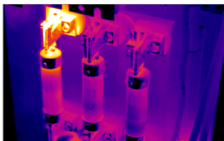
Contrôle d'armoires électriques
