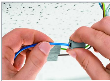
Raccordement du conducteur (côté luminaire) :
