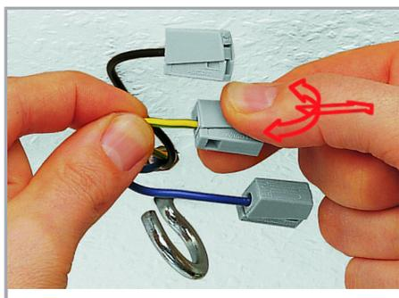
Raccordement du conducteur : introduire le conducteur rigide dénudé dans l'ouverture ronde jusqu'au fond
