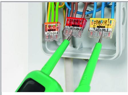
Test possible dans le point de test sur le côté de borne opposé aux entrées de conducteurs
