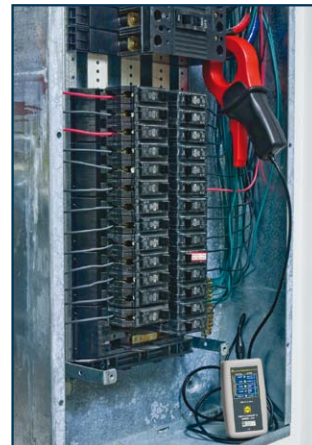
Enregistrement du courant d'un circuit de dérivation avec le L101.
