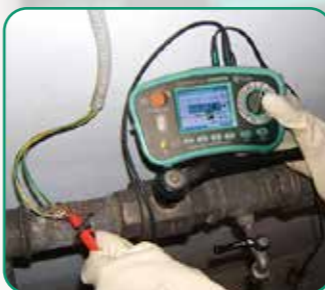
Continuity check of equipotential bonding
