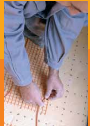
Pose de crampons à l'agrafeuse ou à la main
