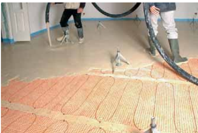
Coulage d'une chape fluide (sous avis technique pour cet usage)
