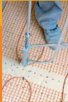
Pose de crampons à l'agrafeuse ou à la main
