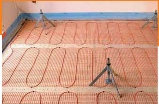
Préparation des niveaux avant coulage
