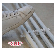
FIX-RING Multi plomberie - clipsage avec le pied
