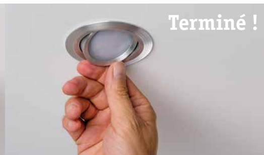
Raccordement simple grâce à la fixation rapide
